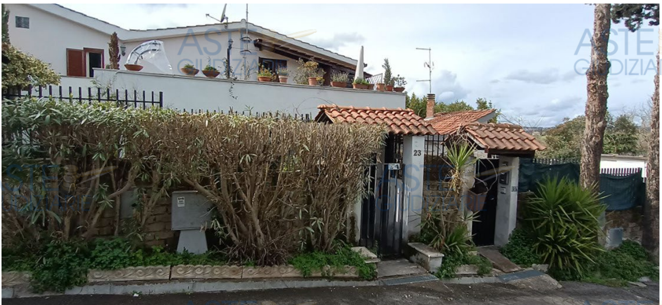
prospetto fabbricato da Via Colle Girello – n.23 cancelletto pedonale di accesso
