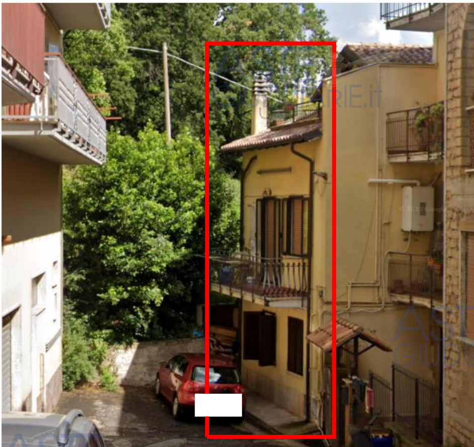
Vista da Via Bellini
