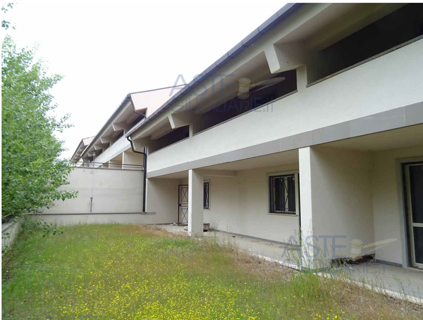
Comparto C3 – Edificio C3C – il giardino pensile del piano terra sul solaio del piano interrato, all'interno l'edificio è allo stato grezzo esternamente risulta rifinito
