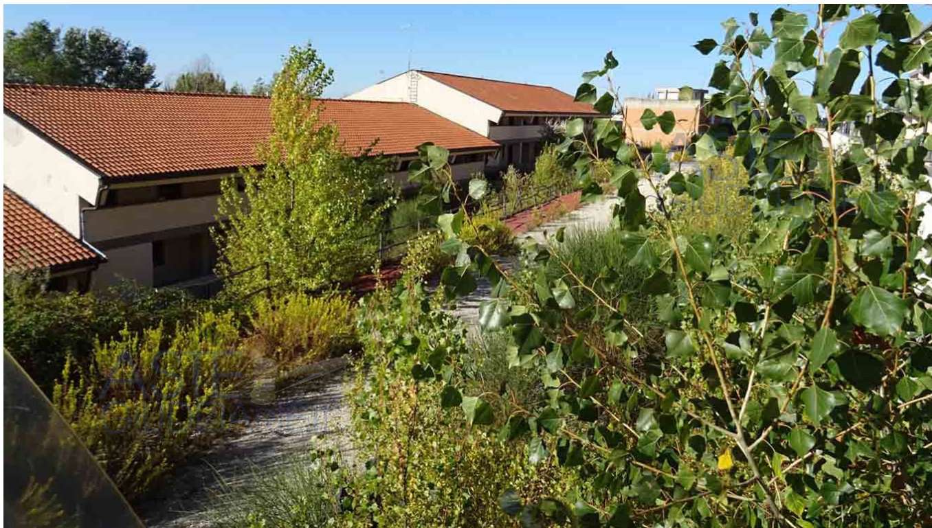
Comparto C3 – Composto da 3 edifici C3A – C3B – C3C
