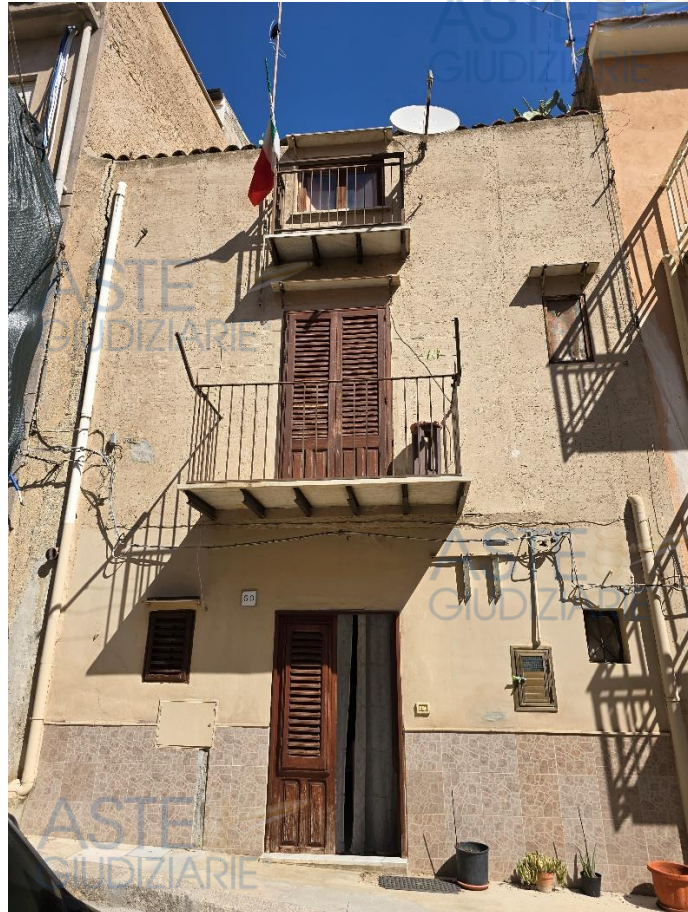
Foto 1. Vista esterna dell'edificio su via Anime Sante n. 50
