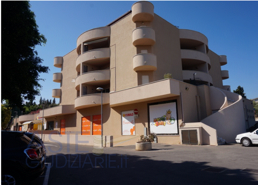
Veduta del fabbricato da area esterna comune
