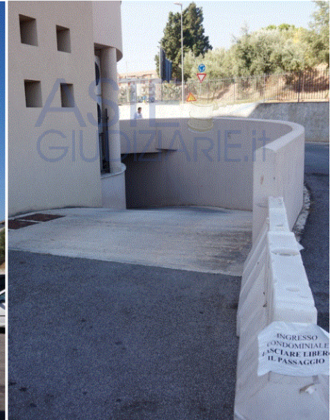
Accesso da rampa carrabile (sub 45)
