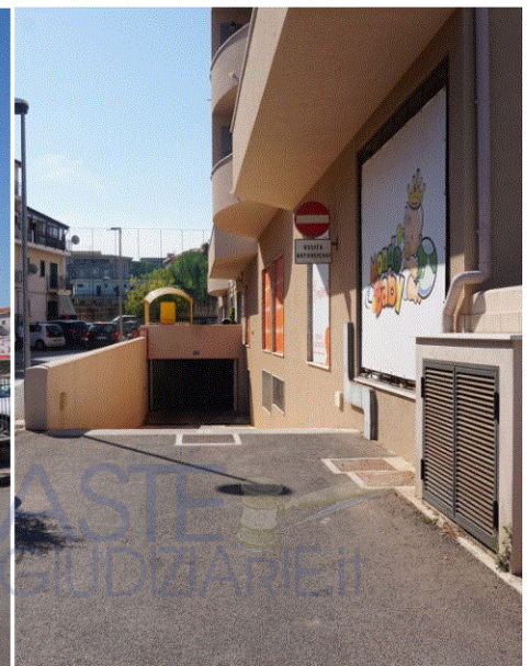
Accesso da rampa carrabile (sub 43)
