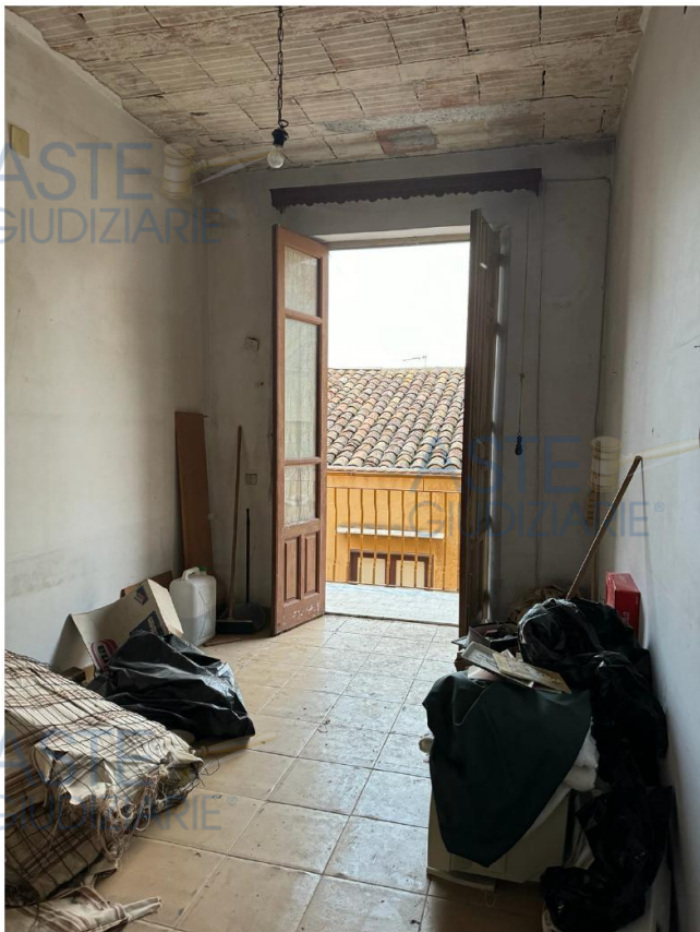
11 | vano al secondo piano
