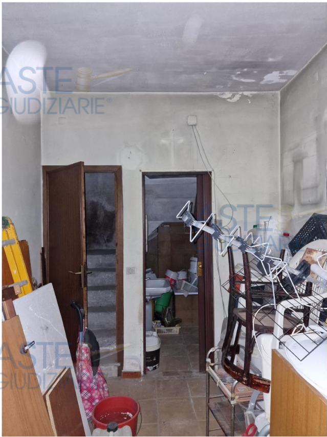
6 | vano d'ingresso al piano terra
