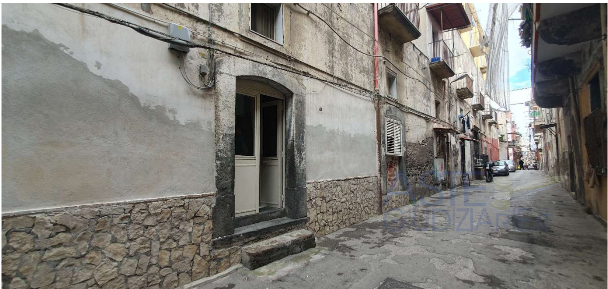
Fotografia 1 – Ingresso dalla via A. Costa.
