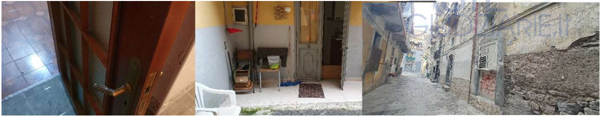
Fotografia 4 – Porte e infissi.
