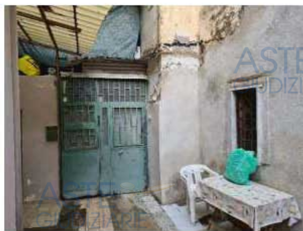
Ingresso da androne comune (non utilizzato)
