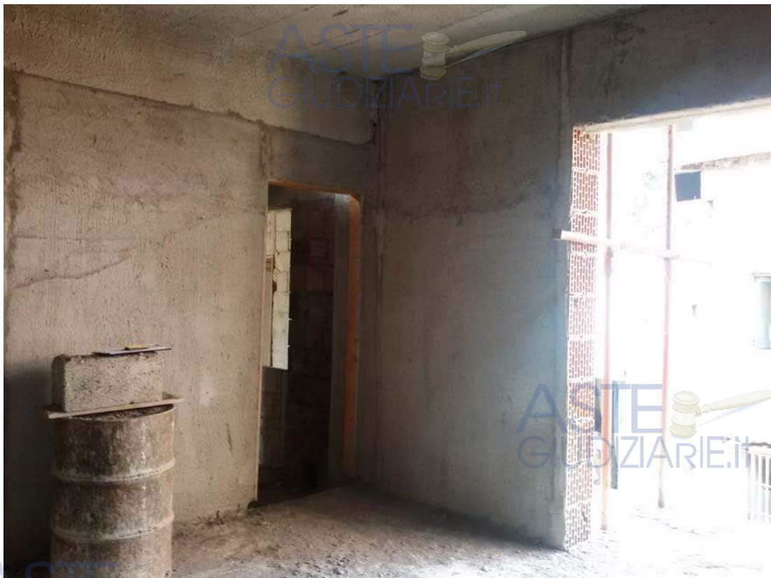
Vista d'insieme del Locale 10
