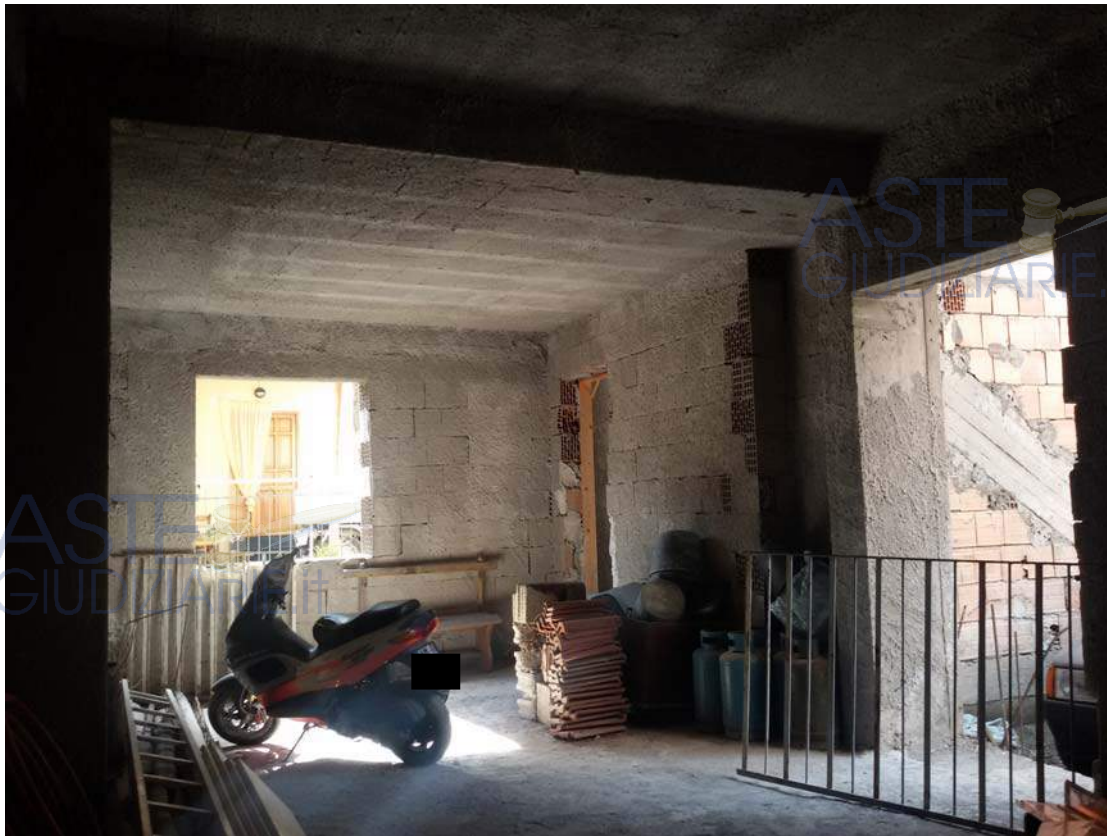
Vista d'insieme del Locale 3
