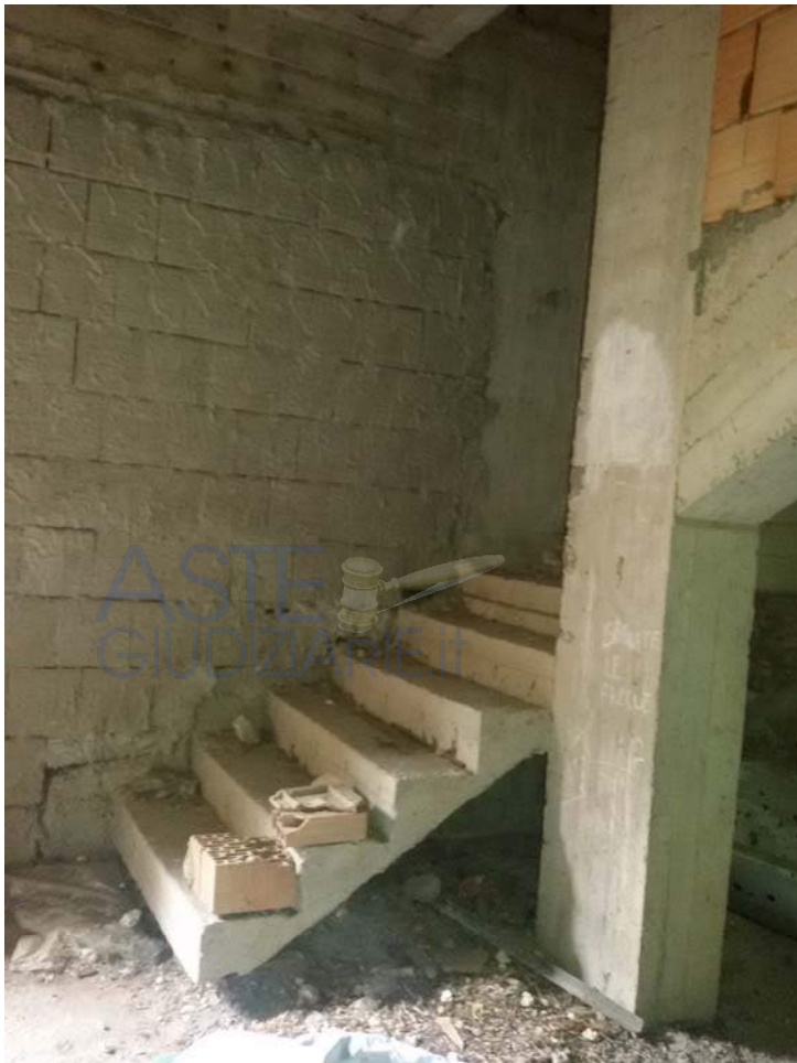
Scala che conduce al piano primo
