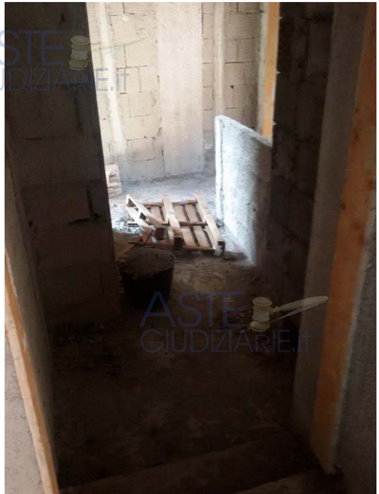
Vista d'insieme del Locale 8
