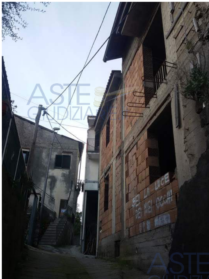
Prospetto edificato su Via Casa Cuomo II
