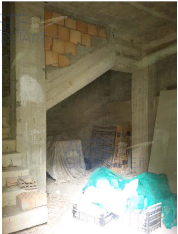
Vista d'insieme del Locale 5
