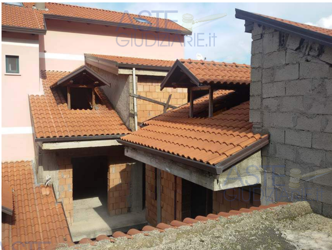
Vista esterna dei sottotetti
