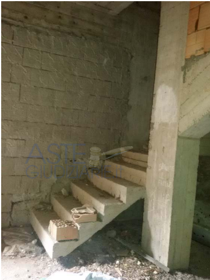
Scala che conduce al piano primo
