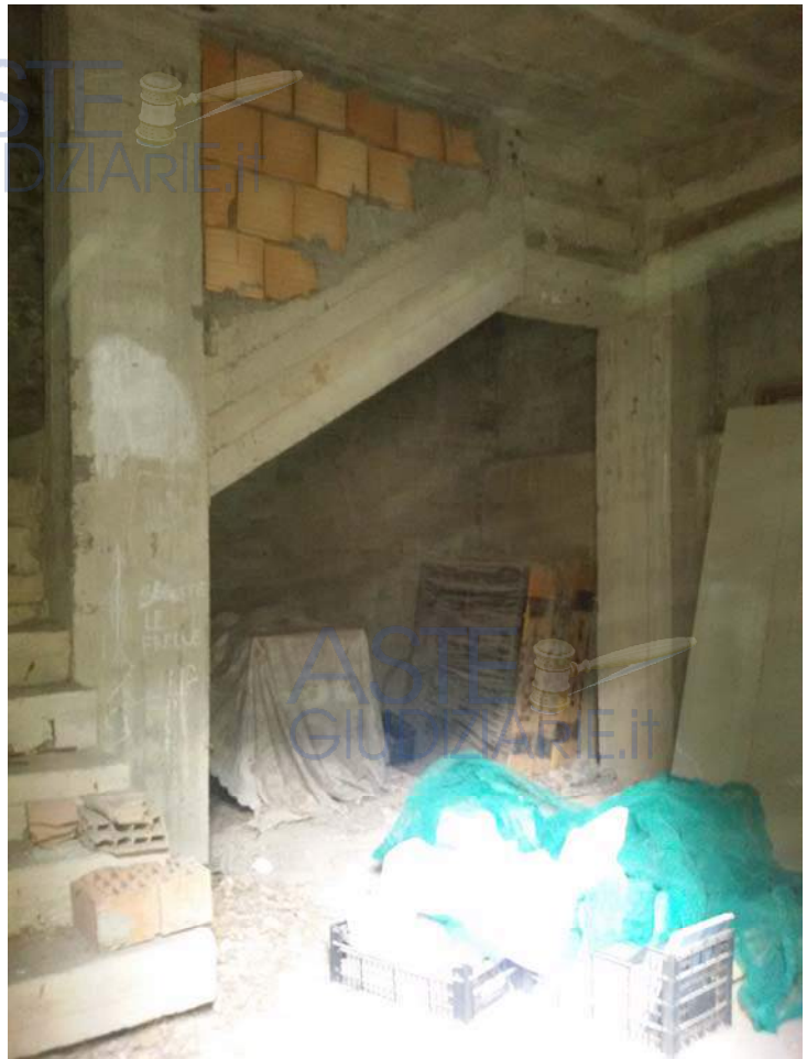
Vista d'insieme del Locale 5
