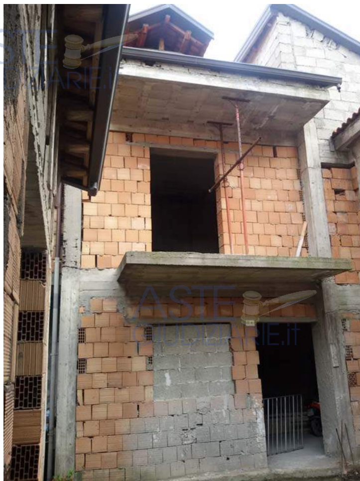
Prospetto edificato su cortile interno
