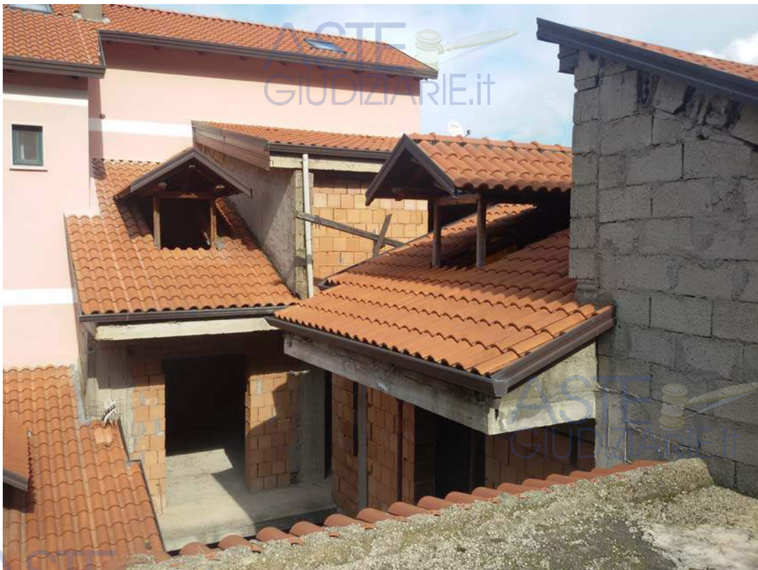
Vista esterna dei sottotetti
