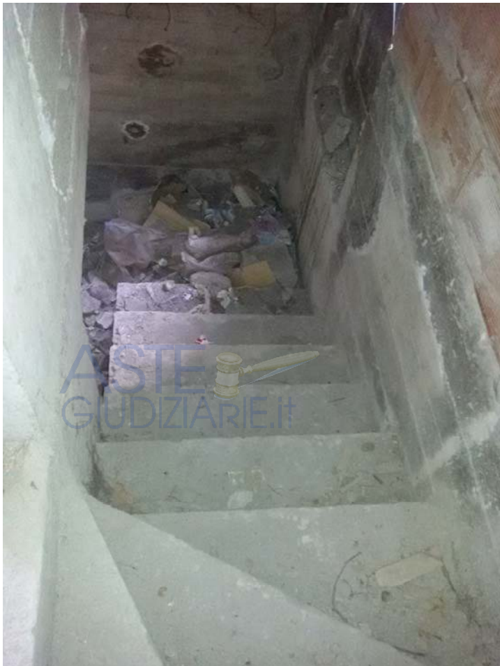
Scala che conduce al cantinato
