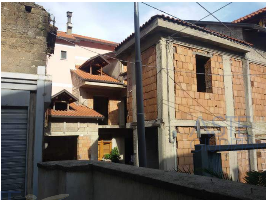
Vista d'insieme dell'edificato
