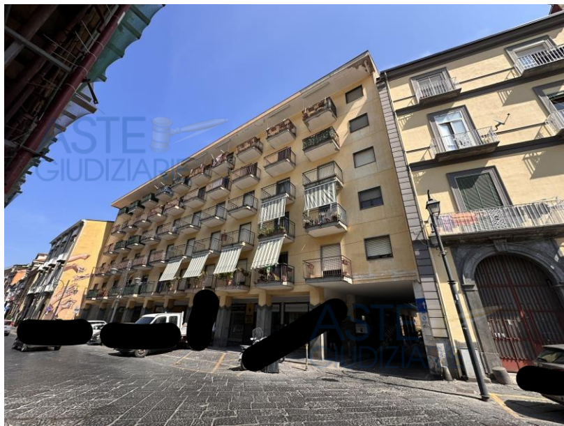
Prospetto principale dalla Via Roma
