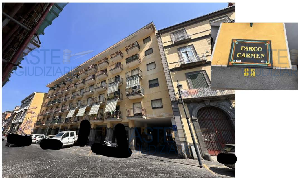
Prospetto principale dalla Via Roma
