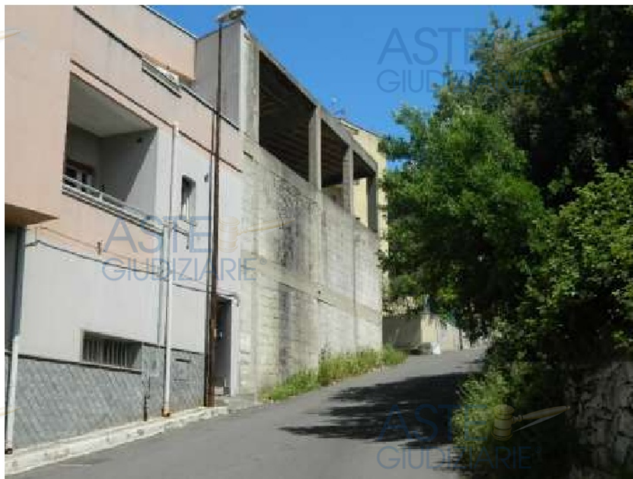
FOTO N° 5.2 – Vista dell'immobile da via del Pozzillo
