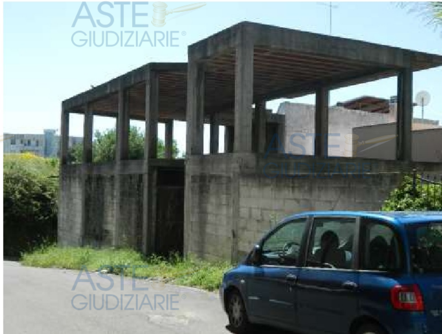
FOTO N° 5.1 – Vista dell'immobile da via P. Lamanna
