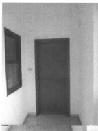
FOTO – porta di ingresso
