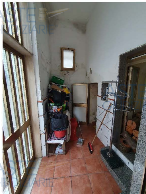
Foto 2 – Ingresso piano terra
