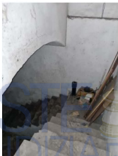
Foto 17 – Scala di accesso al seminterrato
