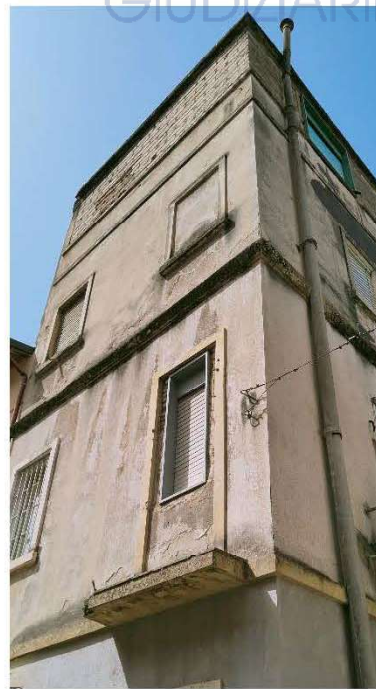
Foto 2 prospetto lato nord
