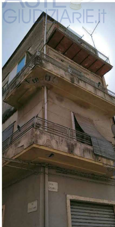
Foto 3: prospetto lato Sud
