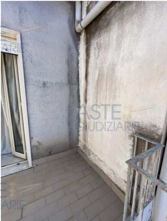
Condizioni di manutenzione esterna
