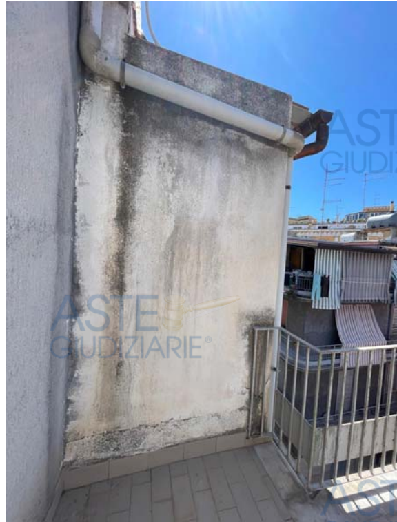
Condizioni di manutenzione esterna
