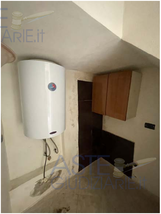
Vista del Wc 02
