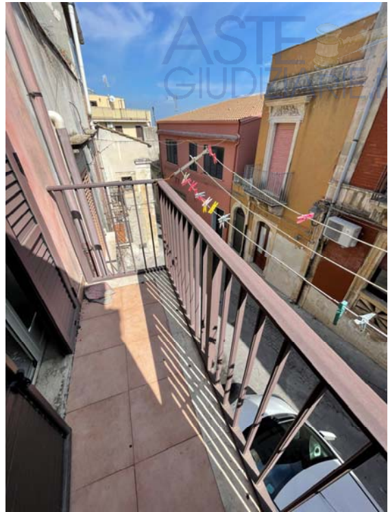
Affaccio sulla Via Arimondi
