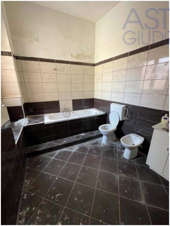
Vista del Wc 01
