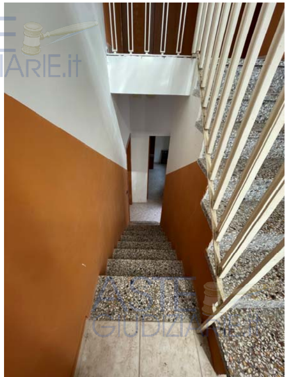
Vista della scala interna in corrispondenza dell'ingresso
