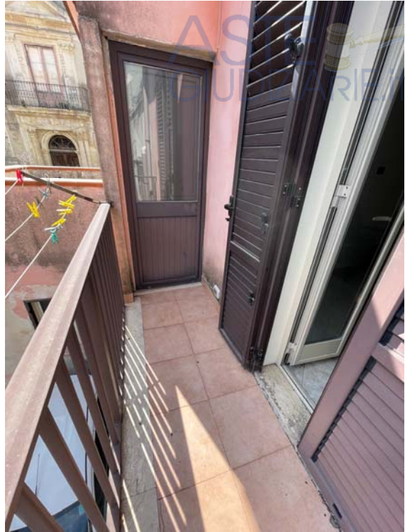
Vista del balcone 02, affaccio su Via Arimondi
