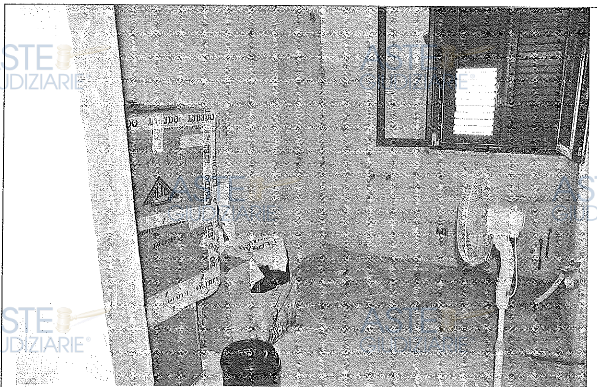
Foto n. 54 – servizio igienico piano secondo
