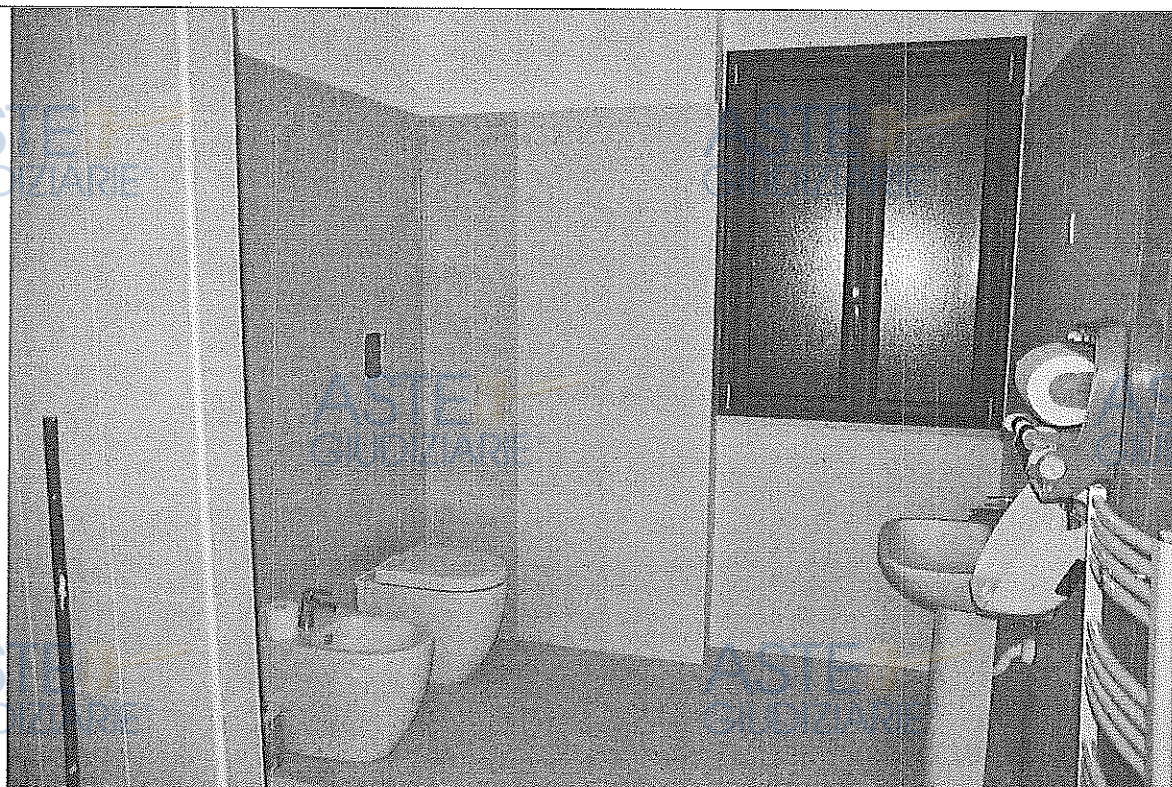
Foto n. 56 – Servizio igienico al piano secondo
