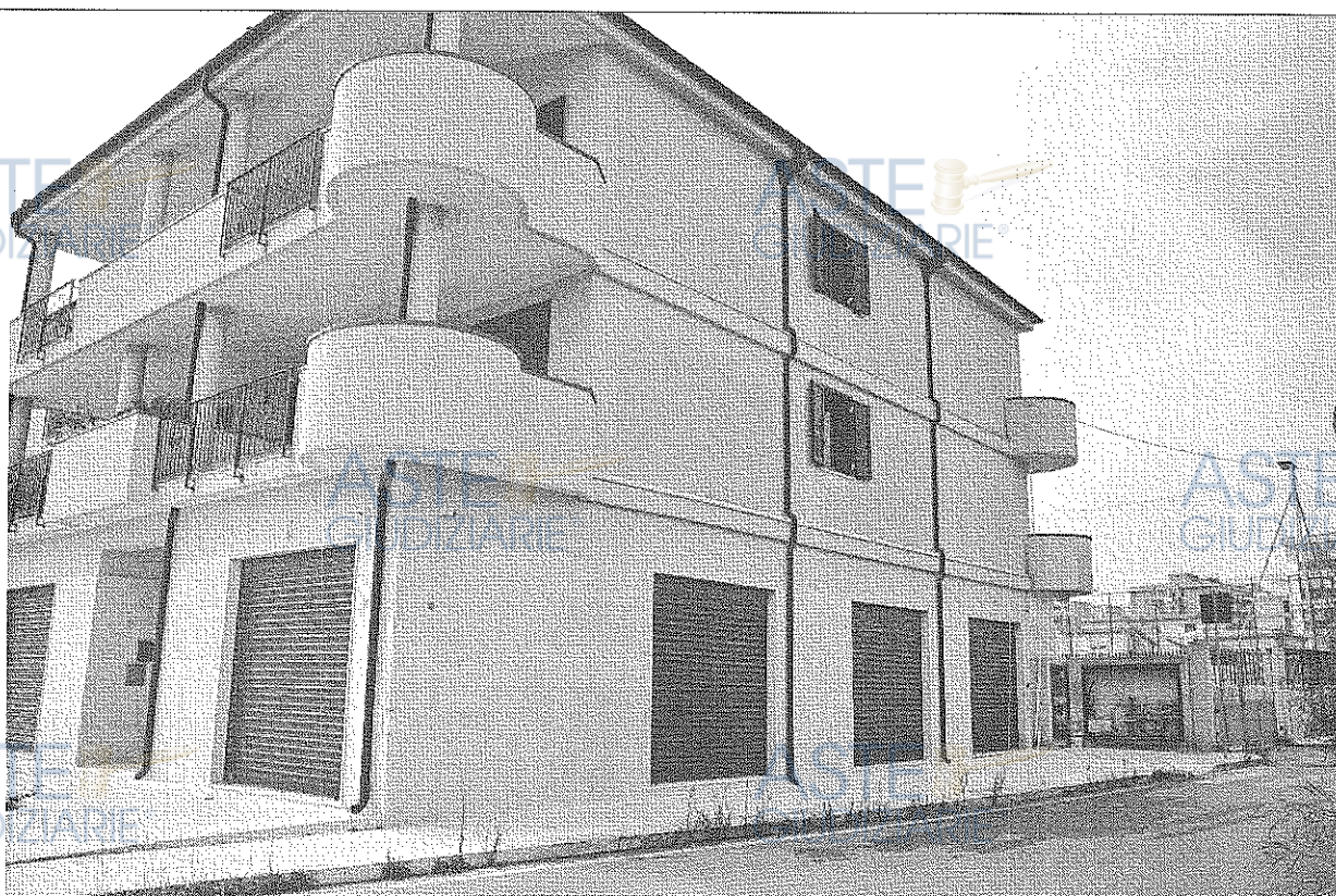
FOTO N.5 – Prospetto dell'edificio lato nord
