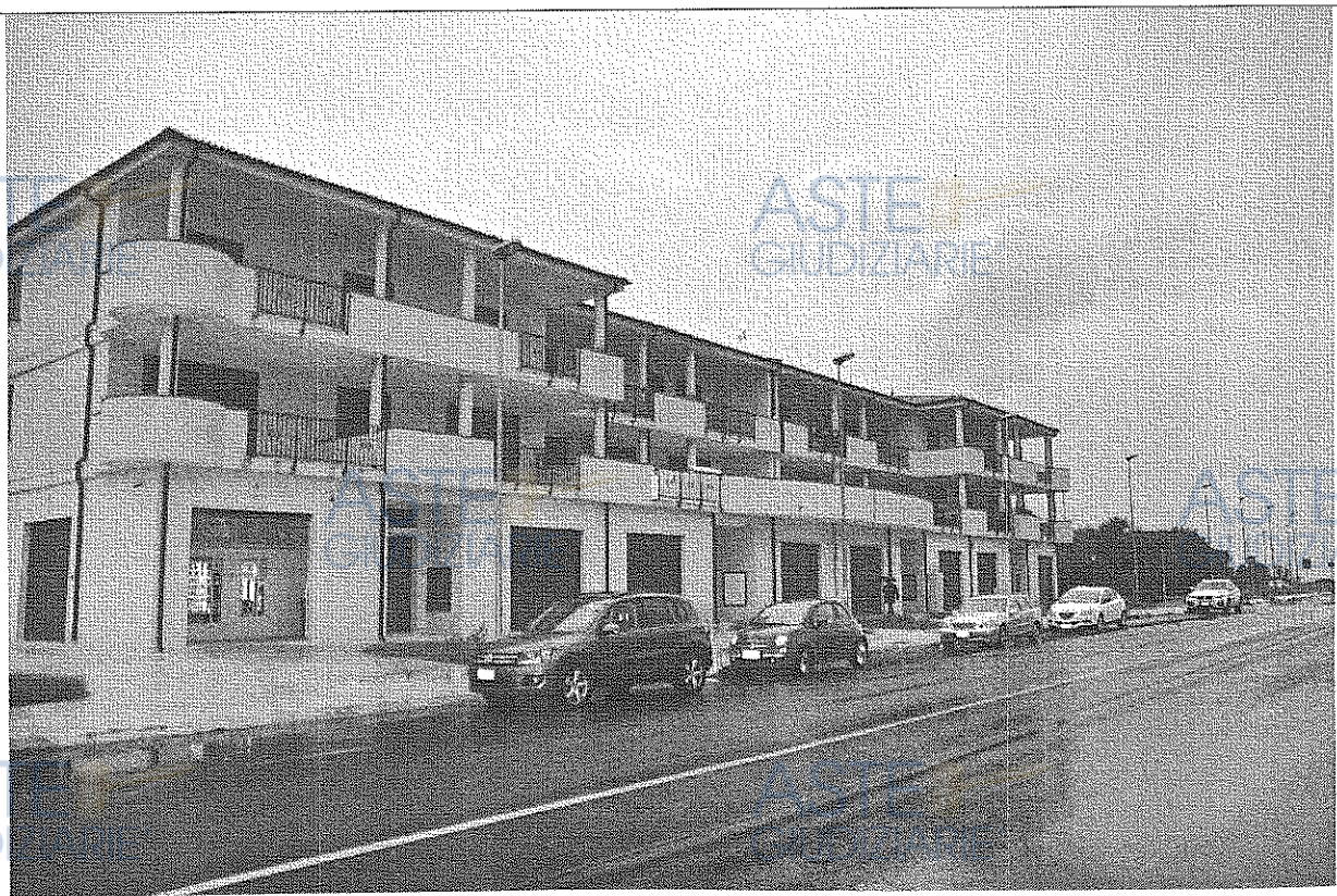
FOTO N.1 – Prospetto dell'edificio lato est
