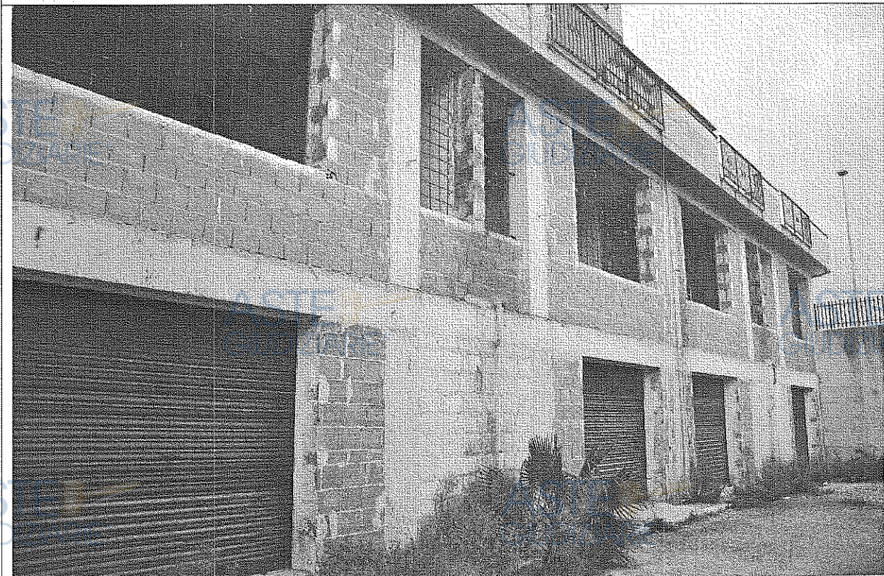
FOTO N.3 – Prospetto dell'edificio lato ovest
