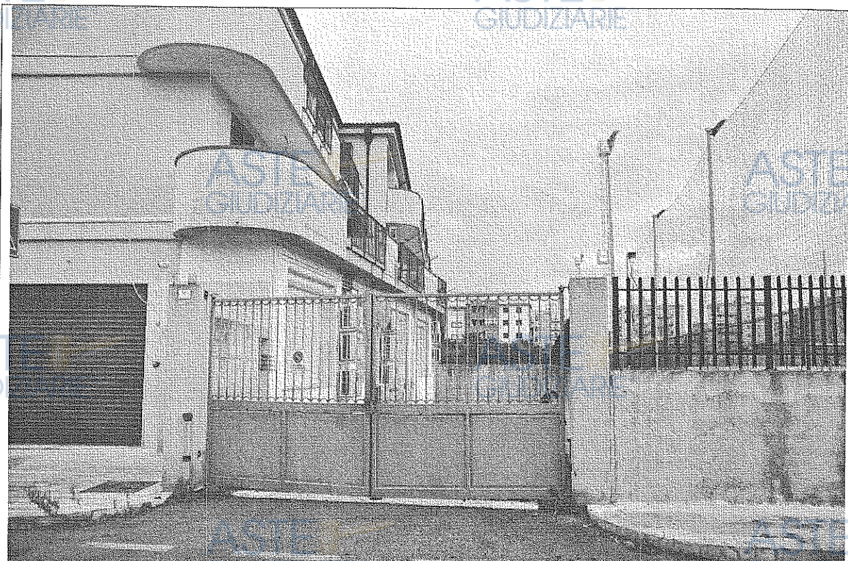
FOTO N.4 – Prospetto dell'edificio lato ovest
