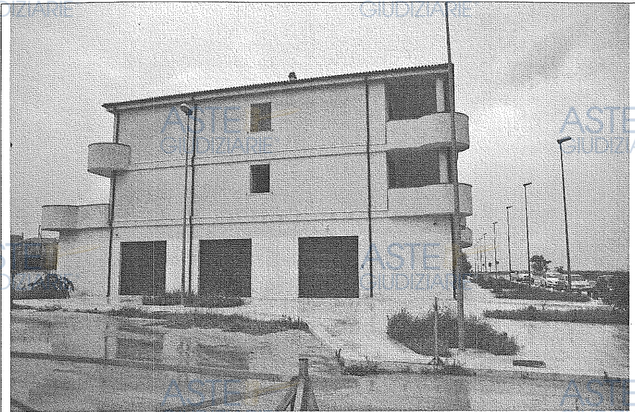
FOTO N.2 – Prospetto dell'edificio lato sud
