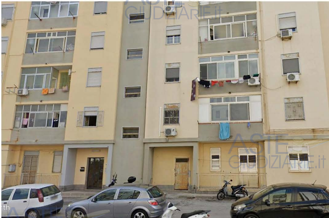
2_l'edificio dall'ingresso di Viale Algeri
