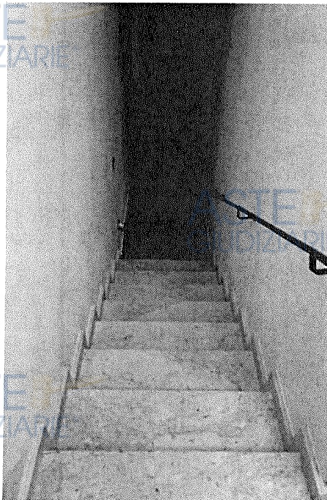
9_la rampa di scale che conduce al piano seminterrato
