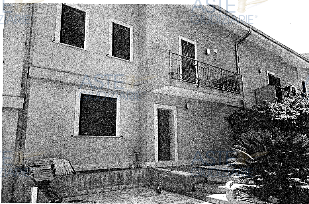
2 L'ingresso al bene dalla Via Archimede
