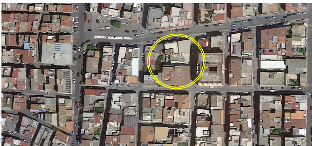
Inquadramento territoriale dell'area in cui è il bene pignorato. Immagini tratte da Google Earth
