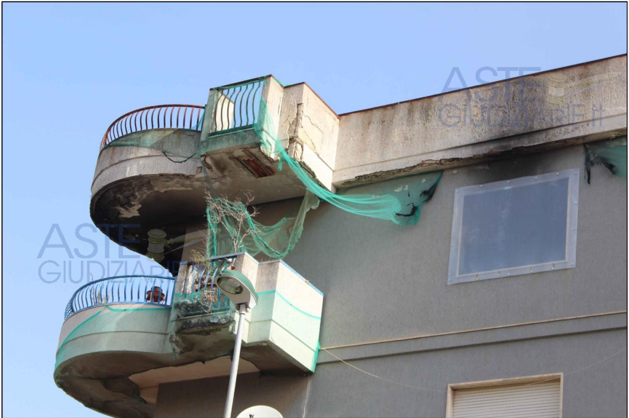
N.3 Vista da Viale Filippo Turati
