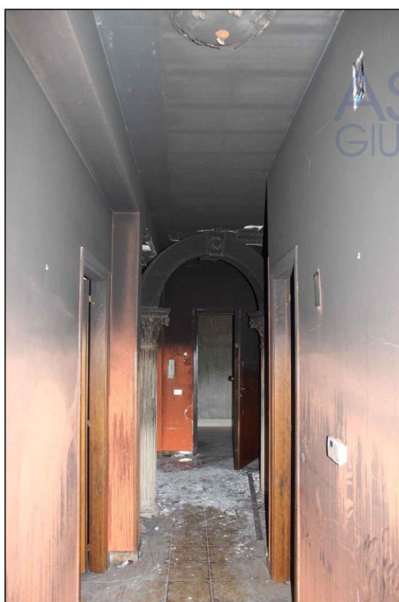
N.16 Corridoio (con vista ingresso)
