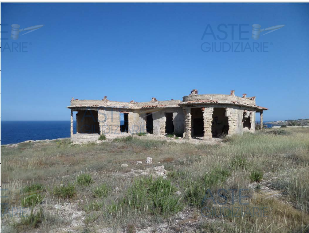
Foto 4 – Particolare del rudere da demolire, insistente sul Lotto a).
