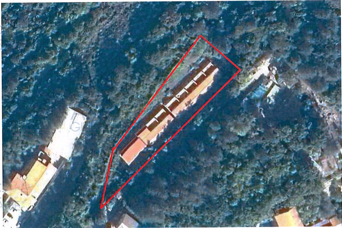
Vista dall'alto - delimitazione dell'area oggetto di perizia contenente gli immobili pignorati
