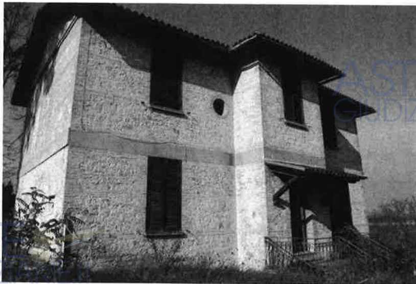
Edificio principale – prospetto ingresso
