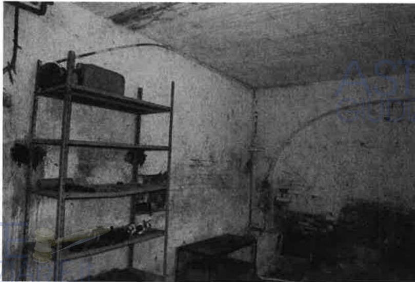
Magazzino al piano terra
