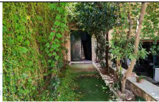
Accesso al vano scala dal cortile
