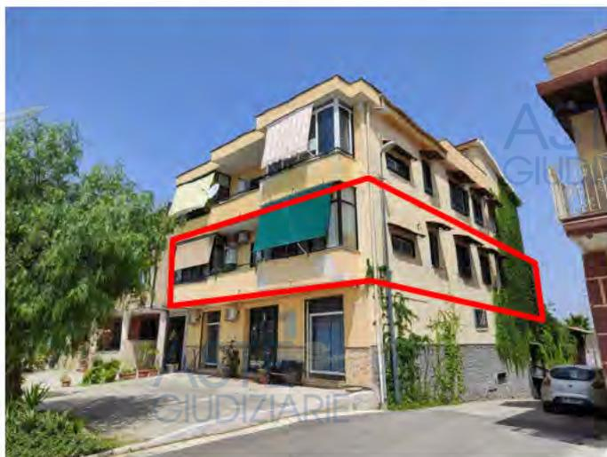
del fabbricato è costituita da un sistema intelaiato di travi e pilastri in calcestruzzo, con solai in latero cemento e con copertura a falde.
