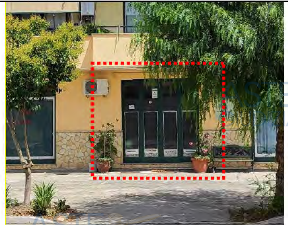
2 -Vista ingresso da SP15 -
