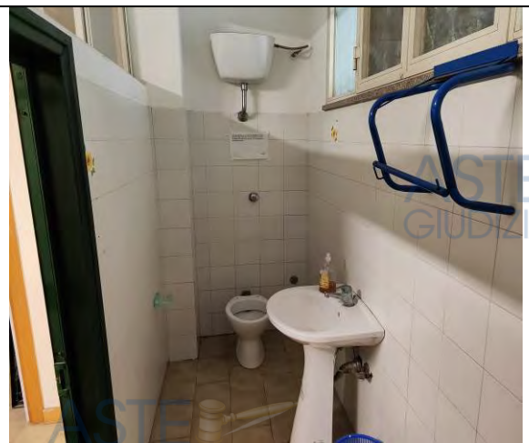
8 -Vista servizi igienici-
