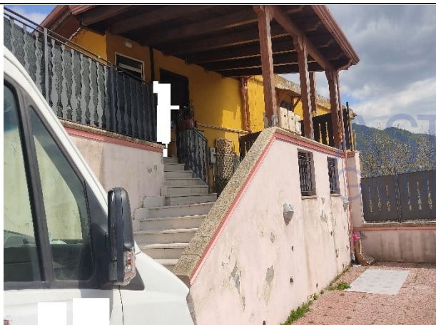
Foto 3 – Particolare della scala e tettoia coperta
