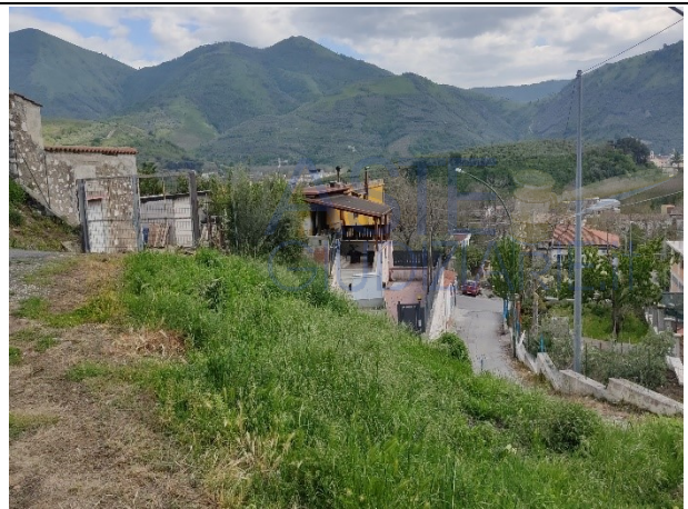
Foto 12 - Vista lato nord
