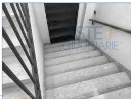
Fotografia 5 - Scala collegamento piano seminterrato
