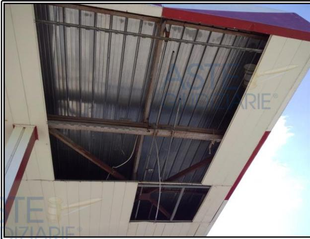
Figura 9 Parziale distacco del rivestimento inferiore
