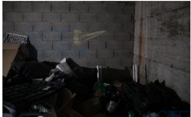
Viste interne del box auto - sub. 20
