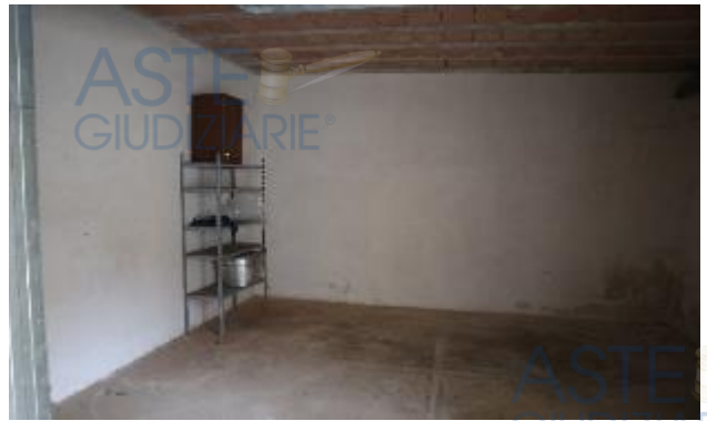
Viste interne del box auto - sub. 48
