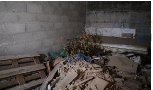
Viste interne del box auto - sub. 42
