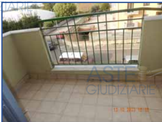
Immagine 9 – Balcone lato Nord
