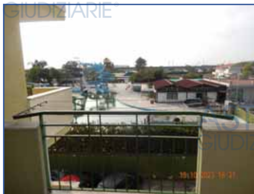
Immagine 10 – Balcone lato Ovest
