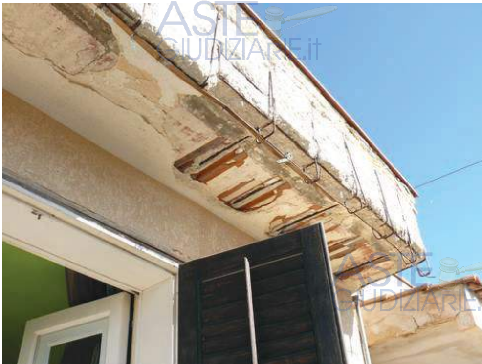
VISTA DEL CORNICIONE DI COPERTURA
