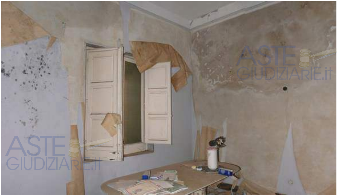
VISTA DI INTERNO A PRIMO PIANO
