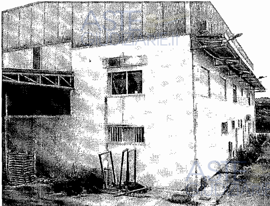
Fotografia n. 12 – Particolare pensilina lato Nord.
