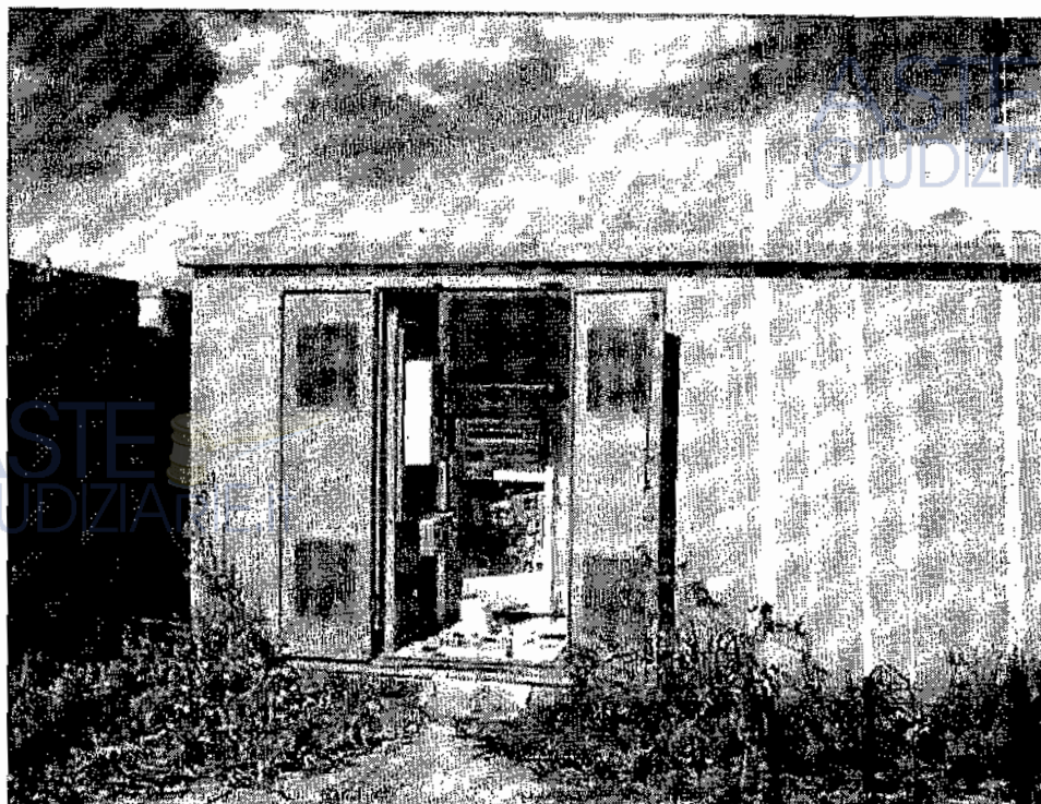
Fotografia n. 37 – Cabina elettrica per alloggiamento trasformatore.
