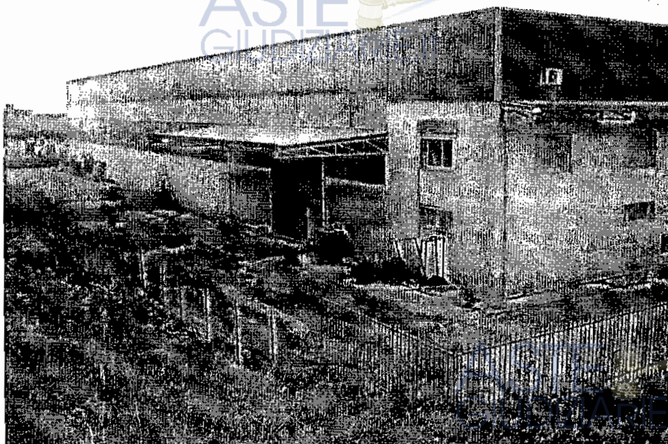
Fotografia n. 16 – Particolare pensilina lato Ovest.
