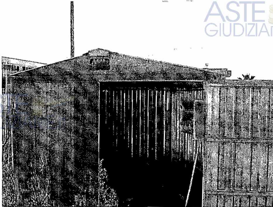
Fotografia n. 39 – Prefabbricato per deposito attrezzi.
