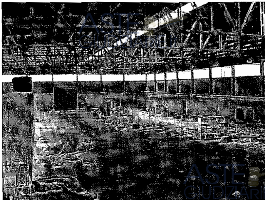
Fotografia n. 24 – Vista interno capannone..
