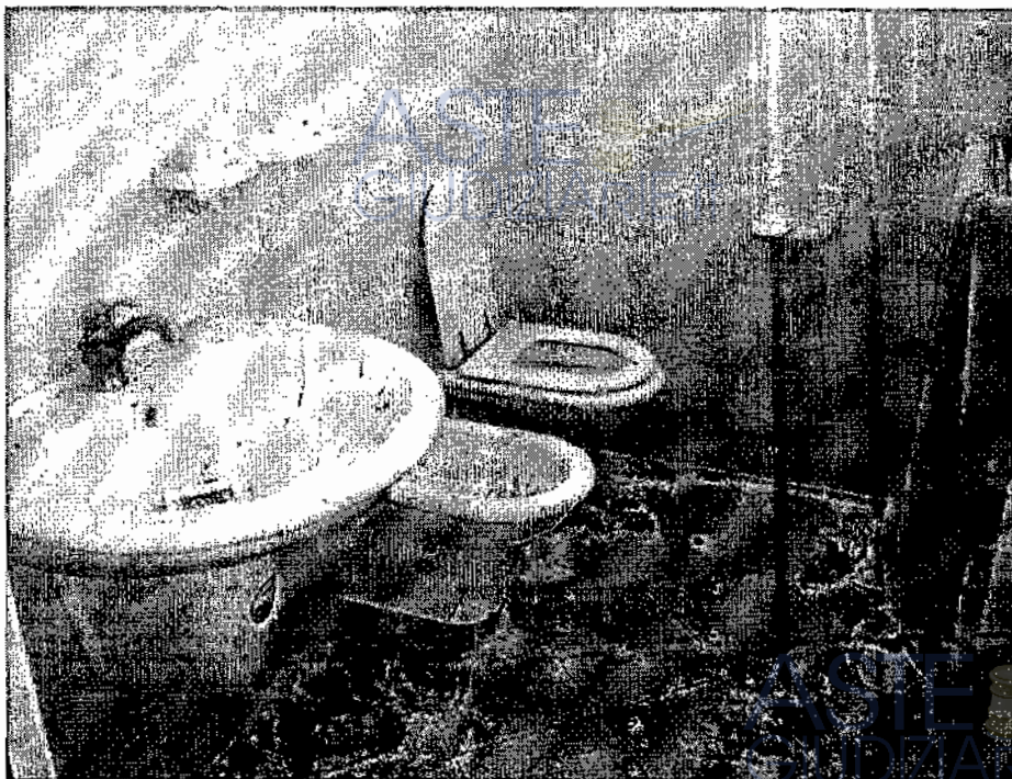
Fotografia n. 34 – Palazzina Uffici – 1° piano. - Wc.
