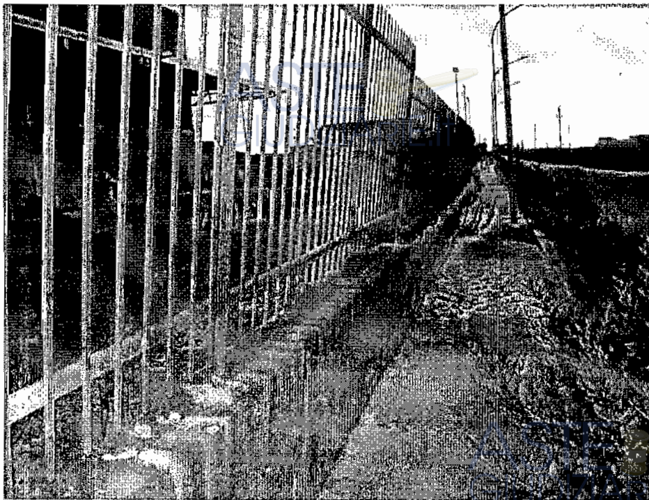
Fotografia nn. 3 e 4 – Vista della recinzione sul fronte principale (lato Est).
