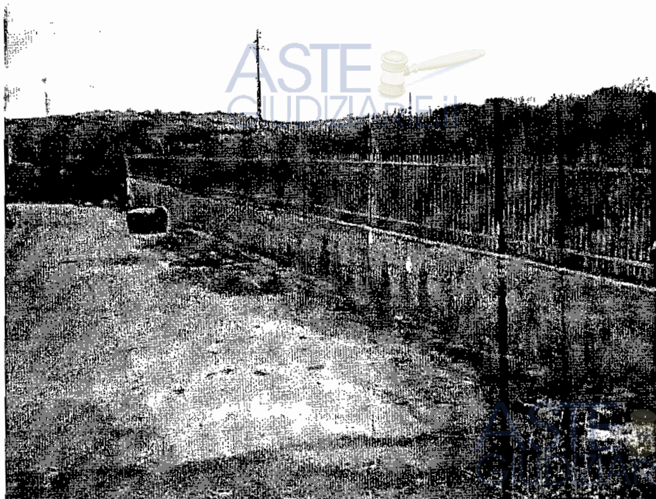
Fotografia n. 14 – Vista recinzione sul lato Nord.
