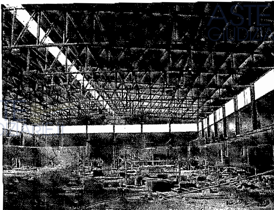
Fotografia n. 23 – Vista interno capannone.
