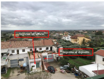
Foto 10 Vista dall'alto del deposito configurato come lotto uno, inserito in un più ampio fabbricato, parl.lla 187.
