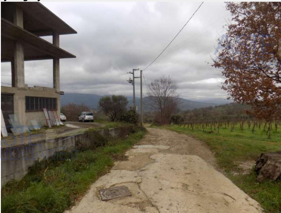
Fig. 9: imbocco della stradina rurale che permette di raggiungere il Lotto Uno dalla rete stradale principale.
