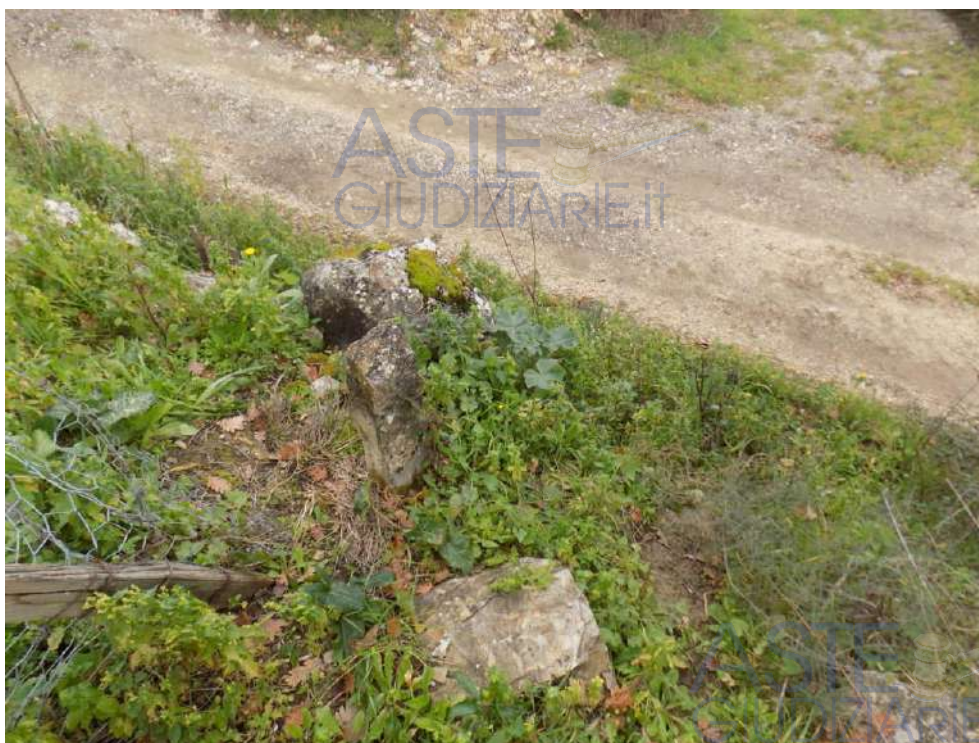
Fig.re 43-44: varco di accesso sul lato nord-est dalla stradina interpodereale non asfaltata. Tale varco è costituito da un gradino in pietrame che permette l'accesso dalla quota più bassa della strada. Il varco si apre tra una recinzione metallica e paletti di legno che ne segna il confine sul lato nord-est.
