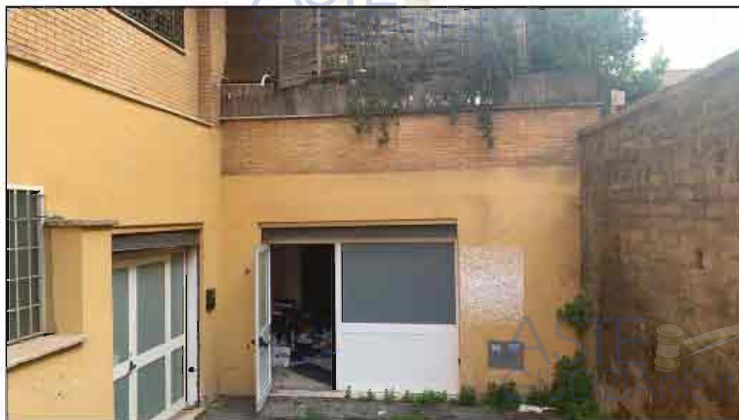
Ingresso dalla rampa carrabile
