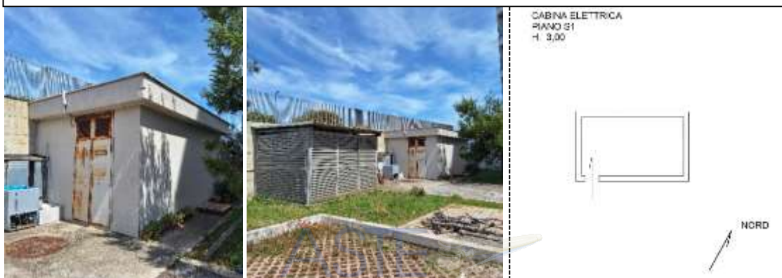
CABINA ELETTRICA FOGLIO 1093 PARTICELLA 512
