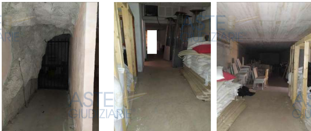
locali di pertinenza collocati al piano seminterrato
