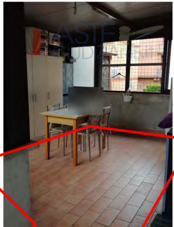
Chiusura abusiva – Piano primo Int. 3c
