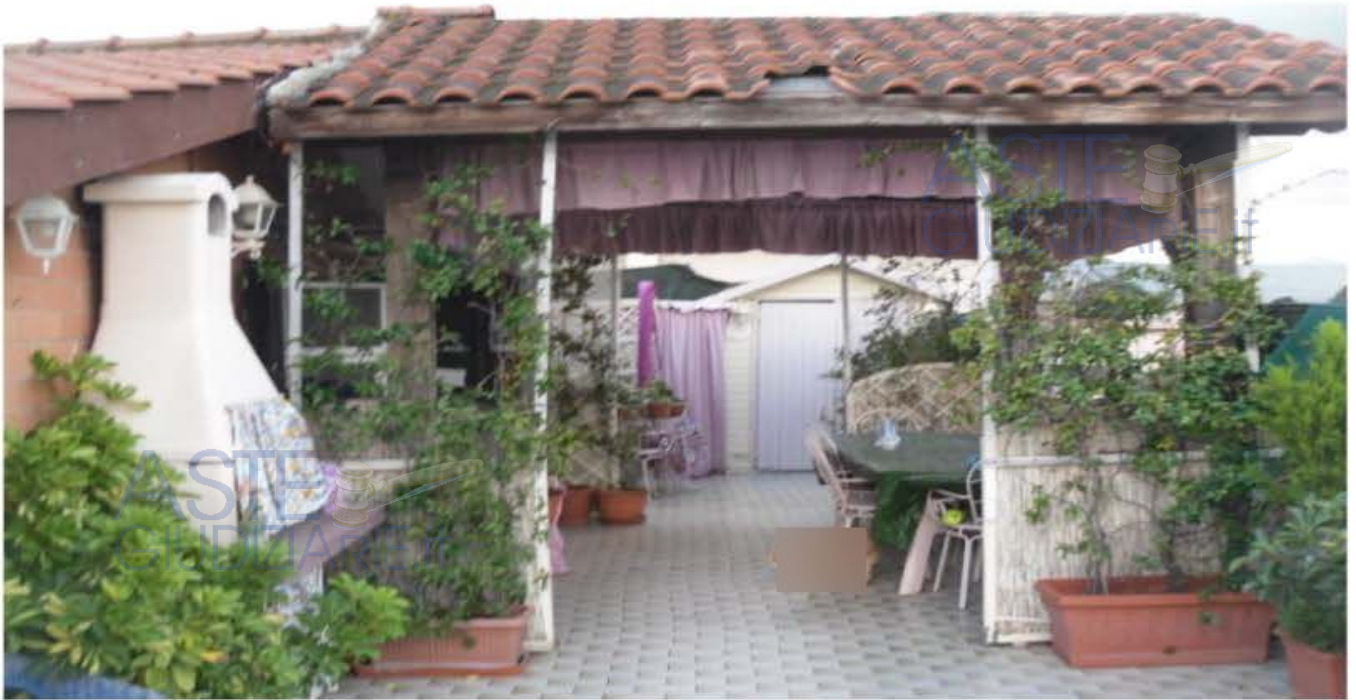
(FOTO ESTERNA - TERRAZZO CON COPERTURA LIGNEA E SOVRASTANTE RIVESTIMENTO IN TEGOLE)
