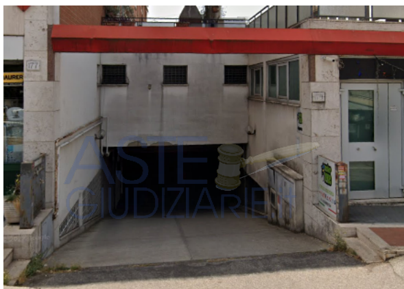
foto dalla rampa di ingresso
