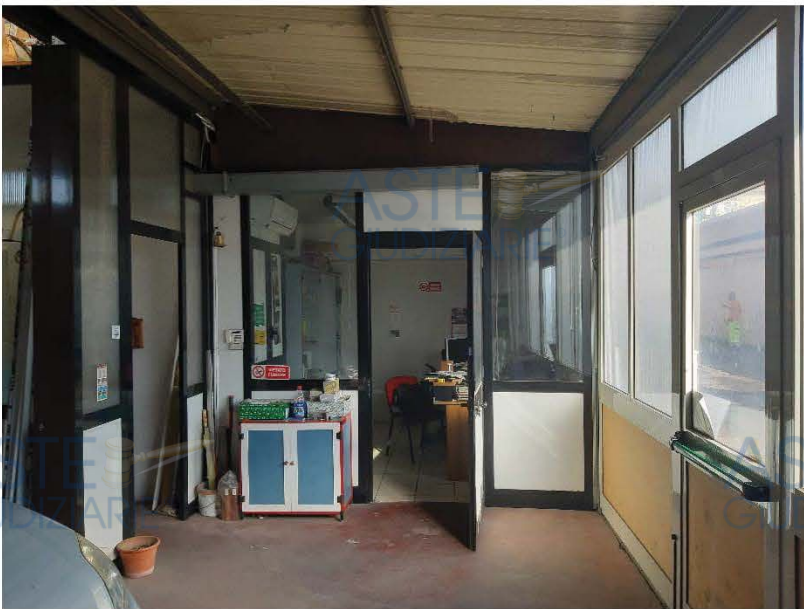
Vista zona uffici
