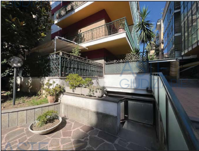
Vista dell'accesso pedonale all'autorimessa
