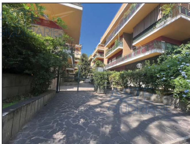
Vista dell'accesso su Via Nomentana 891
