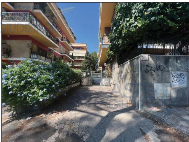
Vista dell'accesso su Via Nomentana 893
