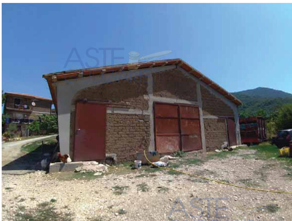
Foto n. 24 Capannone Prospetto sud LOTTO 002
