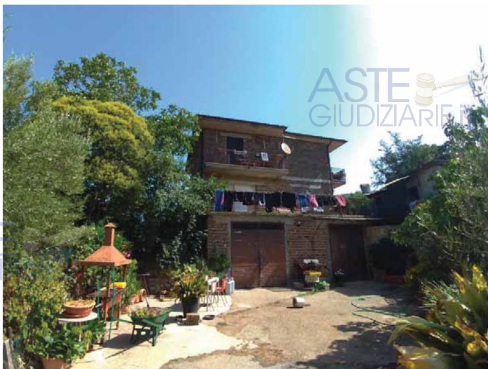
Foto n. 5 Esterno del Fabbricato Prospetto Sud LOTTO 001
