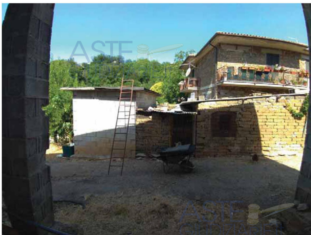
Foto n. 6 Pertinenza Wc- Porcilaia-Magazzino LOTTO 001
