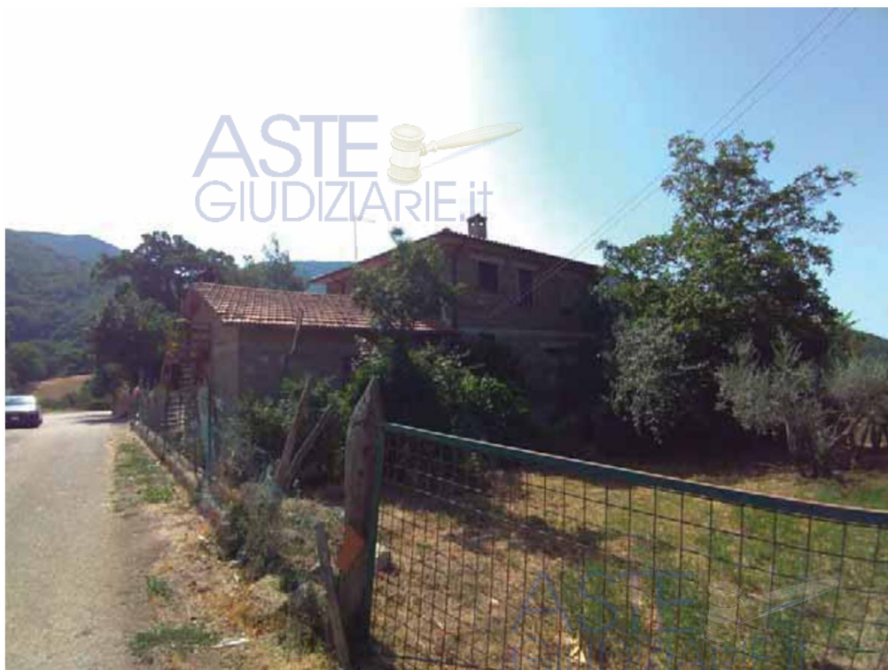
Foto n. 4 Esterno del Fabbricato Prospetto Ovest LOTTO 001
