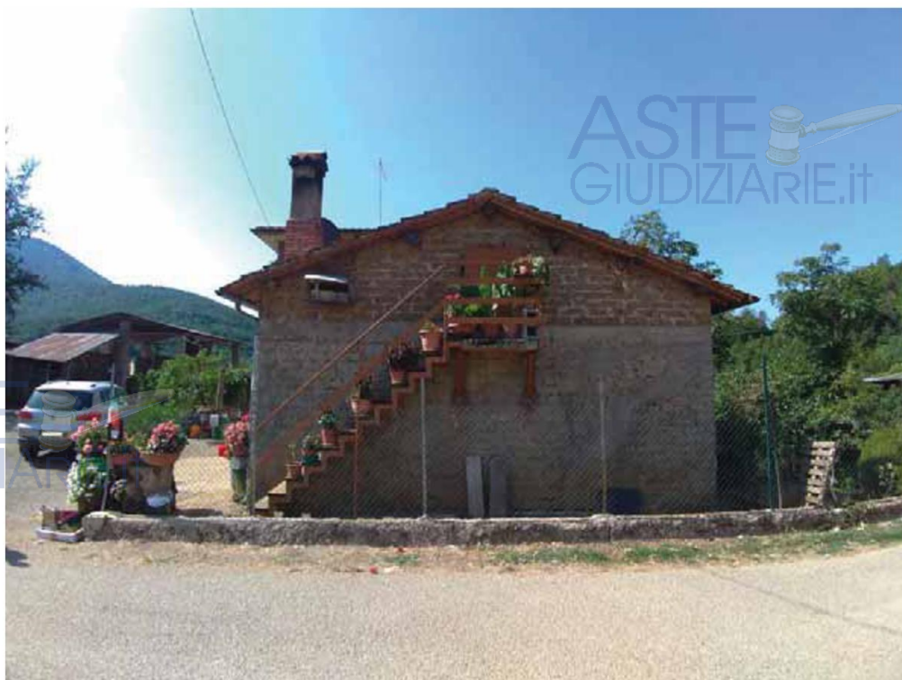
Foto n. 3 Esterno del Fabbricato Prospetto Nord LOTTO 001
