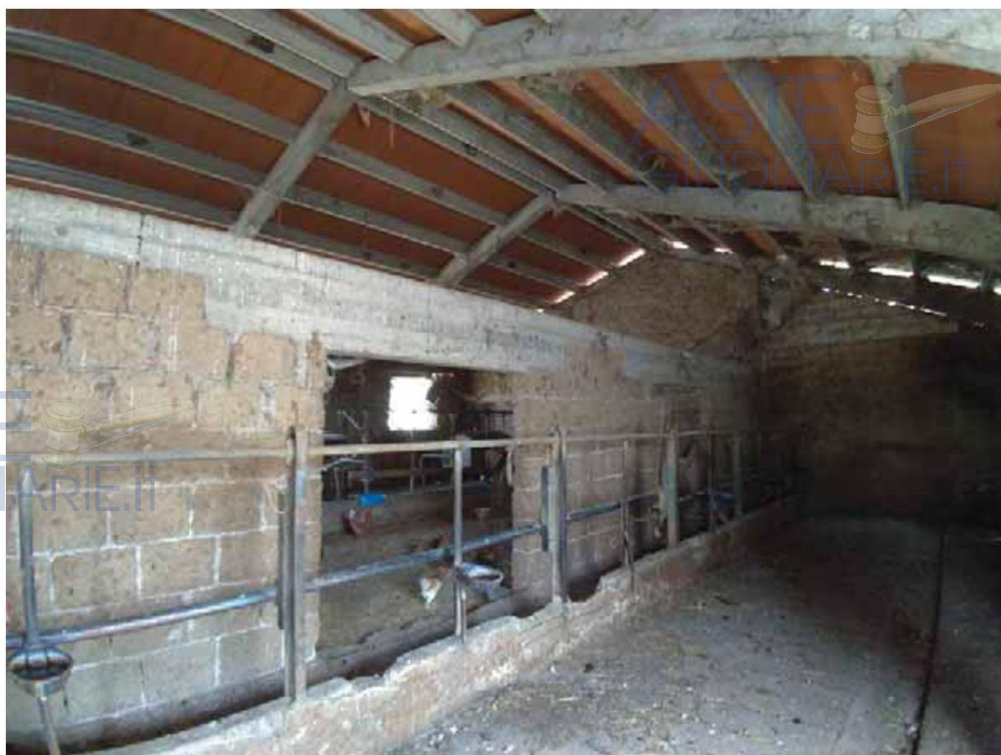
Foto n. 25 Capannone Piano terra LOTTO 002
